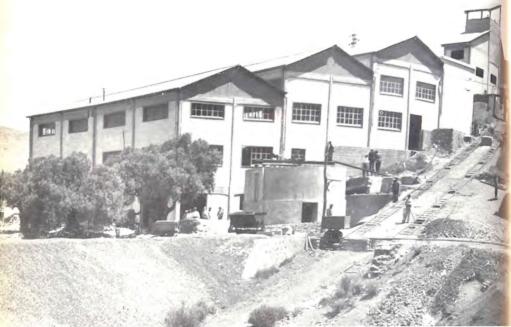
Campo Pisano - Fluttuazione vista da Sud.
